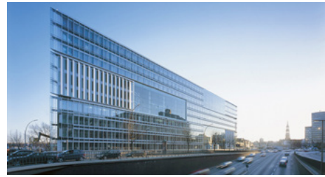
Deichtor Office Center, Hamburg (Alemania) - Detenuto al 100% Nota: gli investimenti realizzati non pregiudicano le acquisizioni future.
