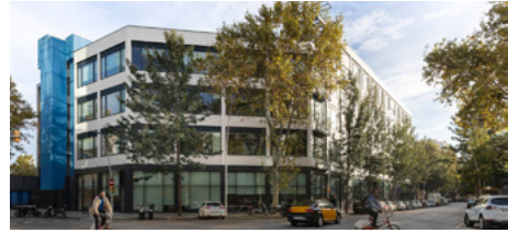
Tanger 66, Barcelone (Espagne) - Detenuto al 100% Nota: gli investimenti realizzati non pregiudicano le acquisizioni future.
